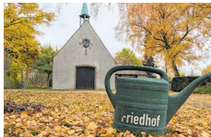
Sanierungsfall: die Friedhofskapelle in Lockhausen. FOTO: THOMAS REINEKE
